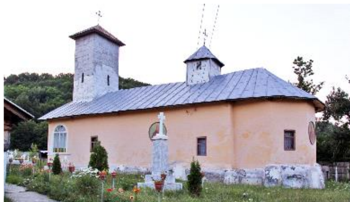
Fig. 28 Biserica de lemn "Adormirea Maicii Domnului"- situată în satul Spătaru. Datează din anul 1900.
